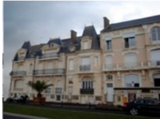
Illustration 45: Immeuble collectif en maçonnerie
