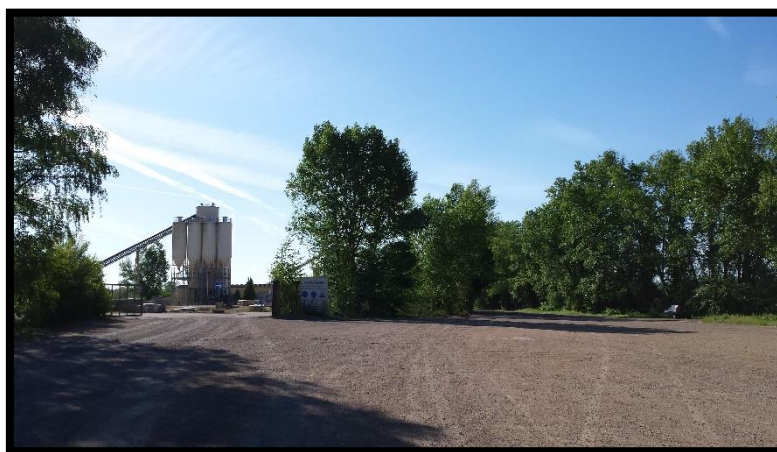
Cimenterie près du fleuve - Crédit photo : Antoine Lambert
