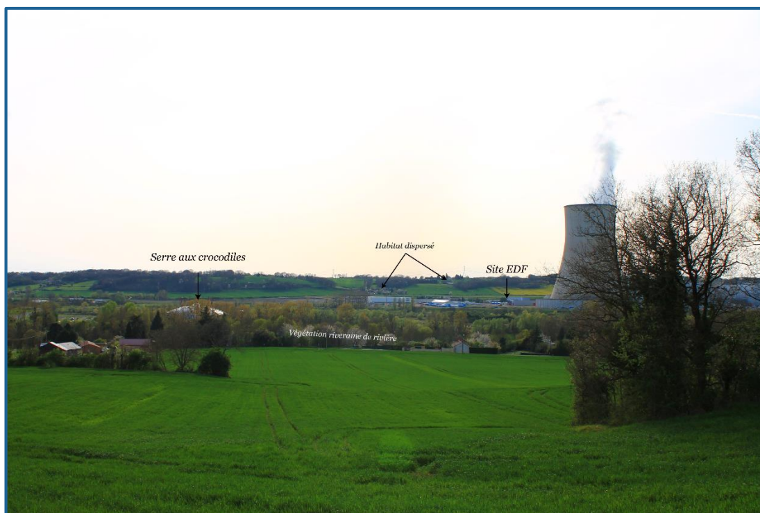
Photographie 2 – Vue sur Civaux
