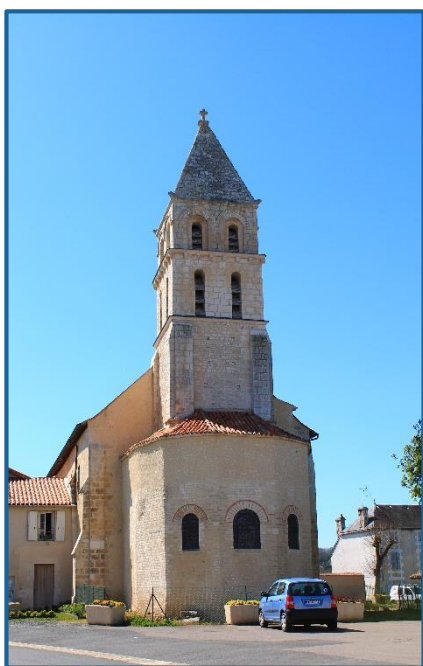
Photographie 1 – Eglise de Civaux
