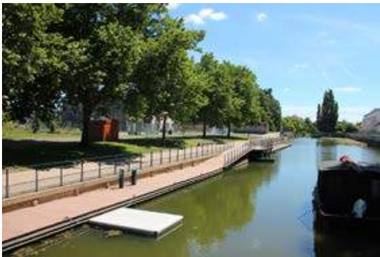
Vue du canal actuellement (source : CHAMBOLLE-CHAMPIGNY-GRELICHE-HELLER)
