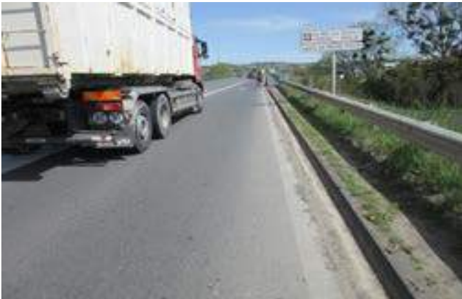
Vue du pont Albert Camus depuis un vélo (source : CHAMBOLLE-CHAMPIGNY-GRELICHE-HELLER)
