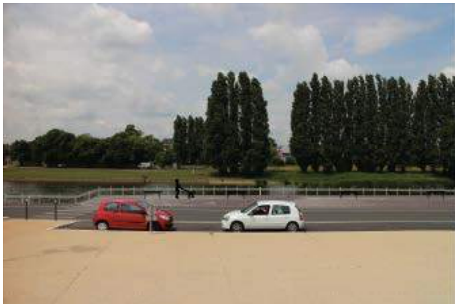
Création d'un ponton en face de l'escalier d'Alaman (source : CHAMBOLLE-CHAMPIGNY-GRELICHE-HELLER)
