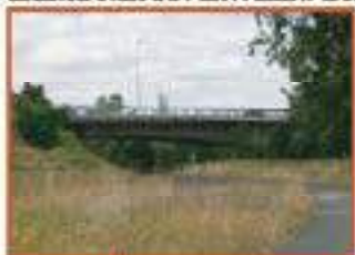
SECURISATION DU PONT ALBERT CAMUS
