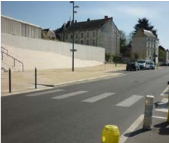
Illustration 34 : Les escaliers derrière l'hôtel Alaman (source : CHAMBOLLE CHAMPIGNY GRELICHE HELLER)
