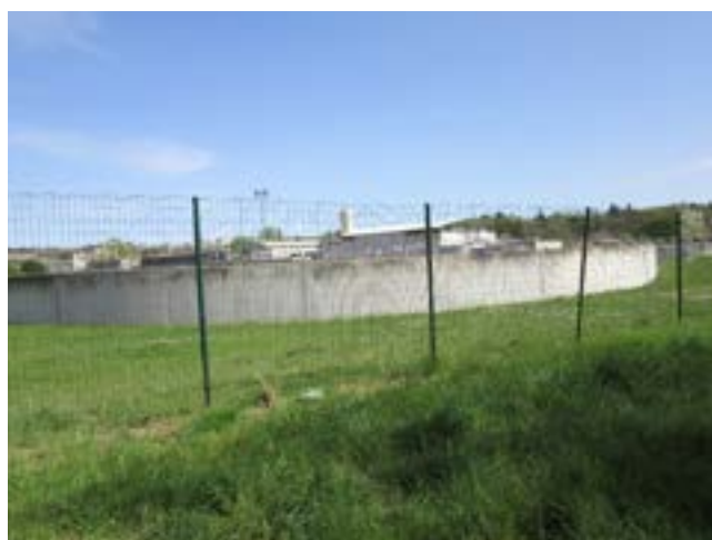
Illustration 23 : La station d'épuration (source : CHAM-BOLLE CHAMPIGNY GRELICHE HELLER)
