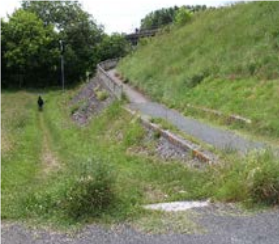
Illustration 67 : Chemin donnant accès à la passerelle du chemin de fer (source : CHAMBOLLE CHAMPIGNY GRELICHE HELLER)
