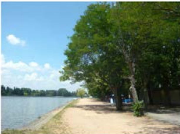
L'esplanade après les travaux
