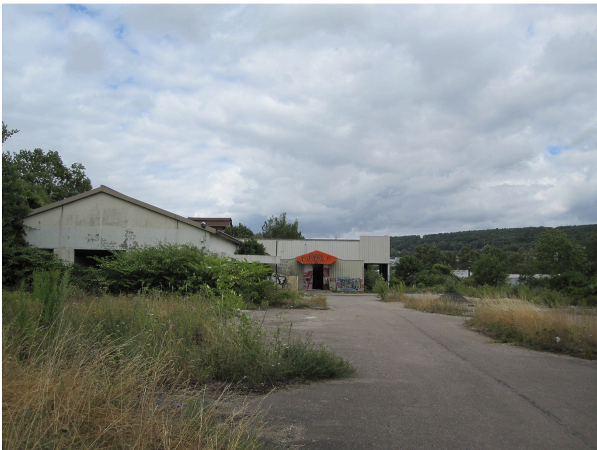
Figure 20 : Terrain numéro 17 (vue vers l'Est), le terrain est en friche et le hangar est abandonné :
