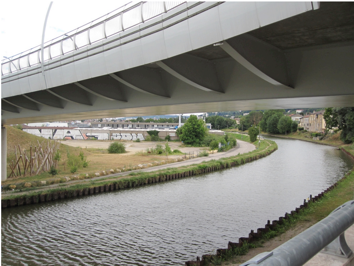
Figure 19 : Vue depuis l'avenue de Metz du terrain 16
