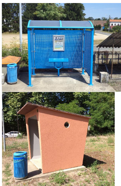
Figure 5 : Abris de quais, Vierzon-Forges et Les Quatre-Roues
