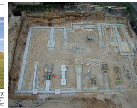
Travaux de fondations de 70 logements locatifs ( Site Weil -BESANCON)
