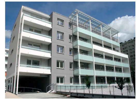
Réception de 70 logements locatifs ( Site Weil -BESANCON)
