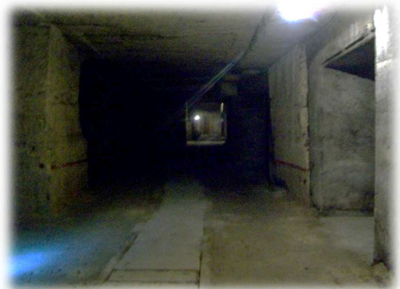
Figure 11 : Galeries typiques des carrières (source personnelle)
