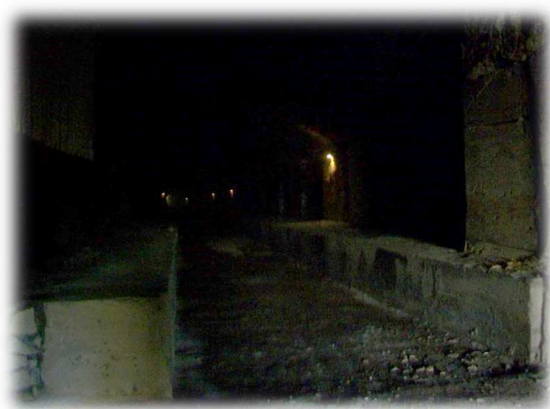
Figure 9: Galeries aménagées en quai de gare (source personnelle).
