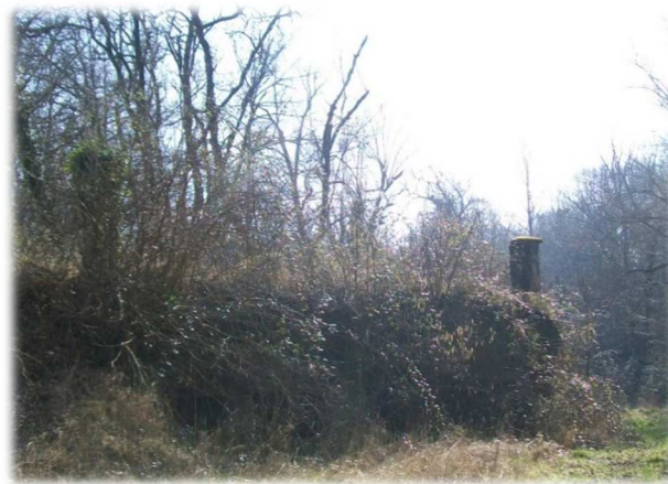
Figure 12 : Cheminées d'aérations (source personnelle)
