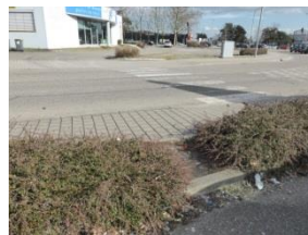
Cheminement piéton non adapté aux usages
