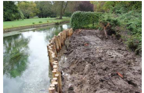
Figure 55 : Exemple de pieux jointifs (source : SAVITON)
