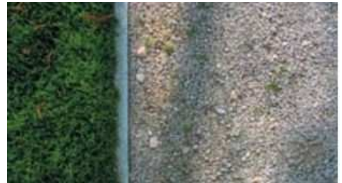
Figure 39 : Revêtement en gravier concassé stabilisé (source : urbanisme-neuchatel)
