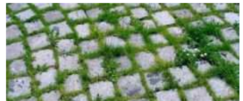
Figure 40 : Revêtement en pavés enherbés (source : Syndicat Mixte d'Action pour l'Expansion de la Gâtine)
