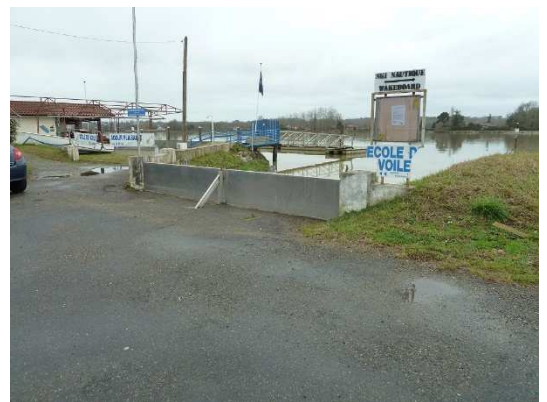
Figure 10 : Batardeau au niveau de la mise à l'eau du port de Lahonce (source : Marion Walter)
