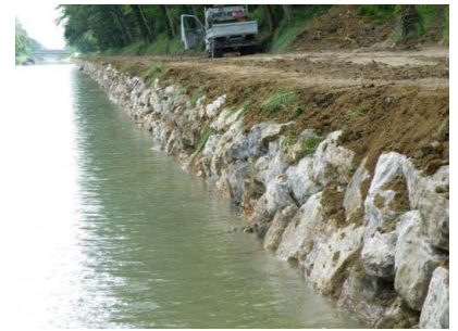
Figure 50 : Exemple d'enrochements (source : JFD TP)
