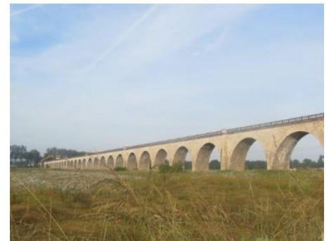
Figure 7 : Viaduc de Gien – Source : Google image
