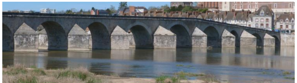
Figure 8 : Vieux pont de Gien – Photo : C. Tagot
