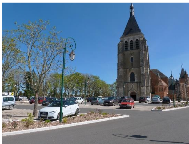
Figure 5 : Eglise Sainte Jeanne d'Arc, Gien – Photo : C. Tagot
