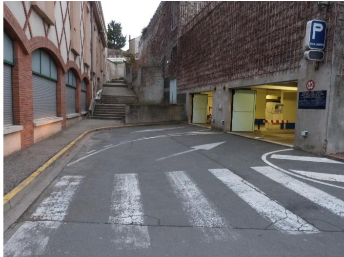
Figure 18 : Entrée et Sortie du parking souterrain – Photo : C.Tagot
