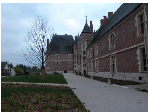
Figure 3 : Cour du Château de Gien – Photo : C. Tagot
