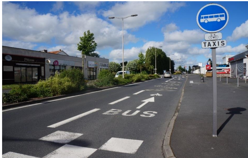
Figure 35 : Piste cyclable Av Maréchal Leclerc Source : B. TESSON
