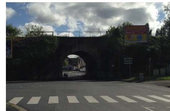
Figure 17 : Pont-de-Pierre Source : B. TESSON
