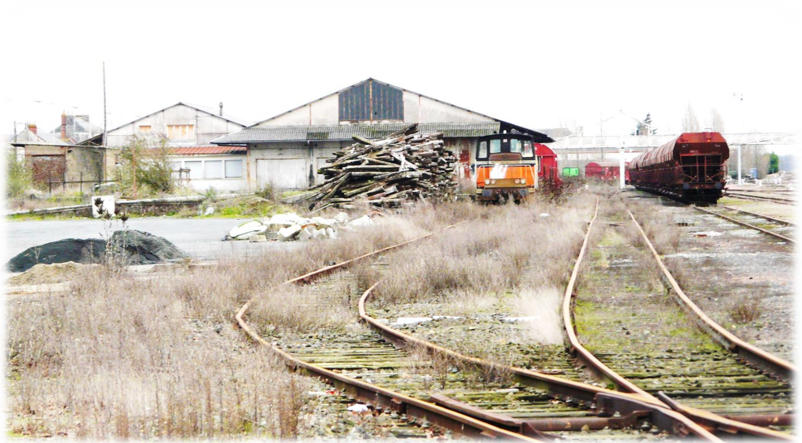
Figure 1 : Friches ferroviaires de Cholet Source : B. TESSON
