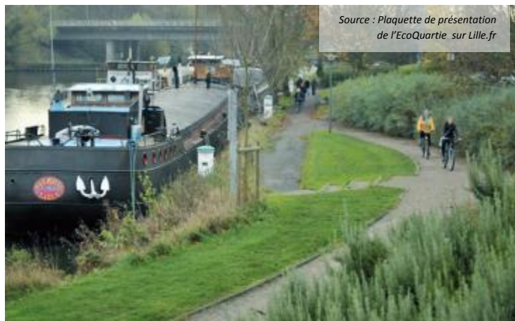
Figure 23 : Illustration des berges aménagées autour de l'eau et de la nature, pour tous les modes de déplacement
