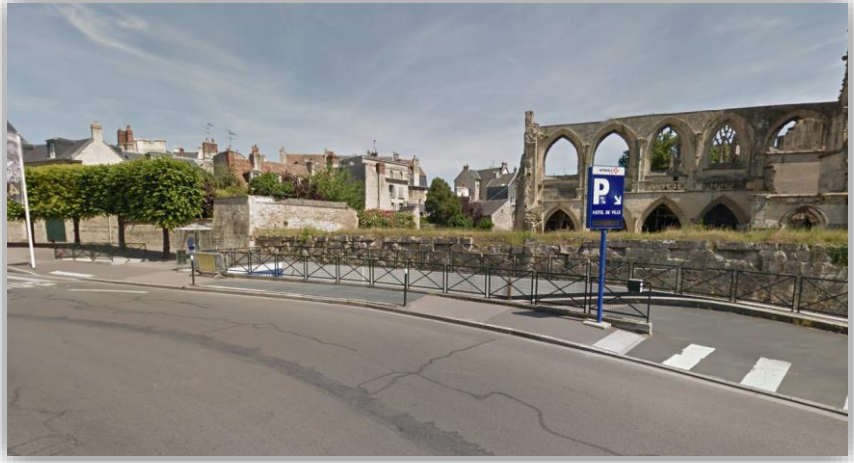
photo 40: Parking de l'hotel de ville de Caen (photo: google street)
