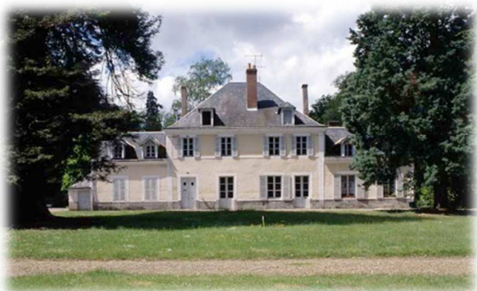
Photographie 14 : Château de la Mi-voie, Nogent-sur-Vernisson. Source : Ministère de la Culture. http://goo.gl/igoENC
