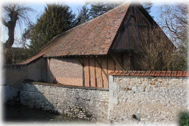
Photographie 15 : Bâtiment remarquable rue Vilmorin. Réalisation : Valérien Poyau.
