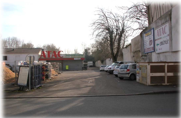
Photographie 31 : Accès du terrain depuis la rue (en période de travaux). Réalisation : Valérian Poyau.
