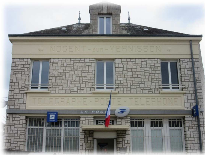
Photographie 4 : Poste de Nogent-sur-Vernisson. Réalisation : Valérien Poyau.
