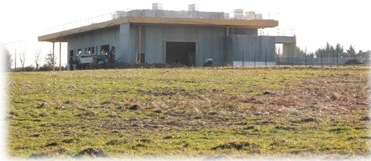
Photographie 8 : Centre socioculturel intercommunal de Nogent-sur-Vernisson en construction. Réalisation : Valérien Poyau.
