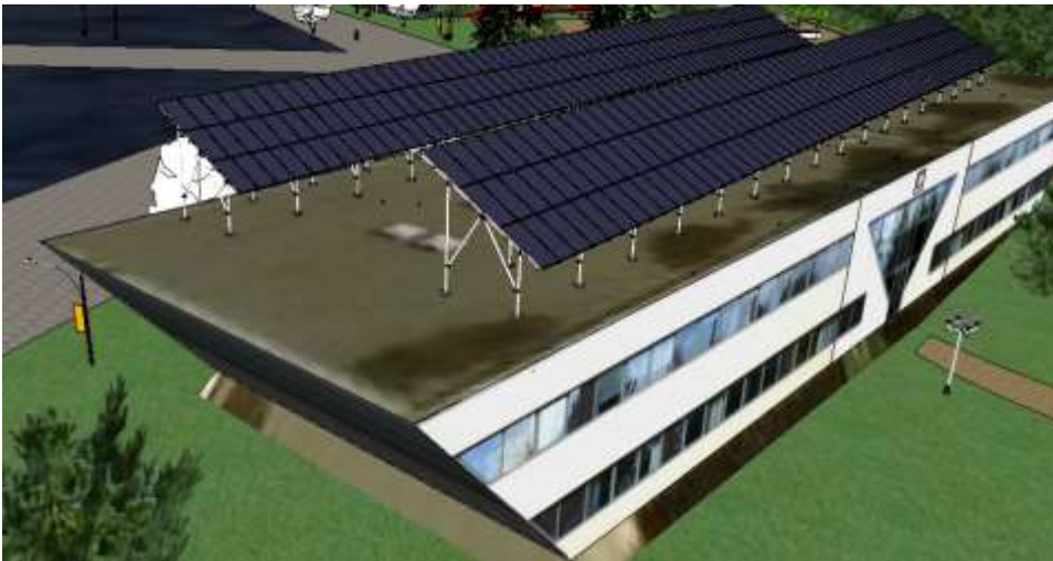
Figure 56 : panneaux solaires photovoltaïques
