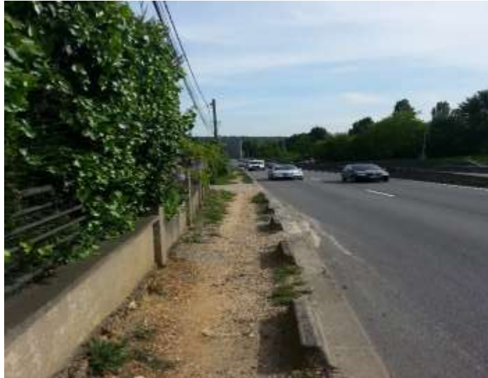
Figure 32 : Accès difficile le long de la départementale
