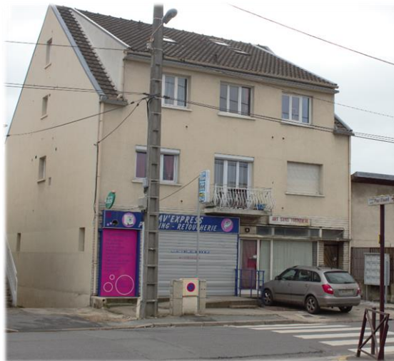
Fig.30 : Commerce le long de l'avenue du Commandant Barré. (Crédits : PICHEREAU Baptiste)
