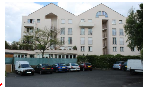
Fig.38 : Résidence adjacente et parking. (Crédit :PICHEREAU Baptiste)
