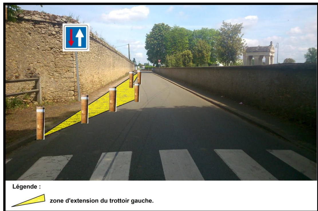
Photo du projet d'extension du trottoir.
