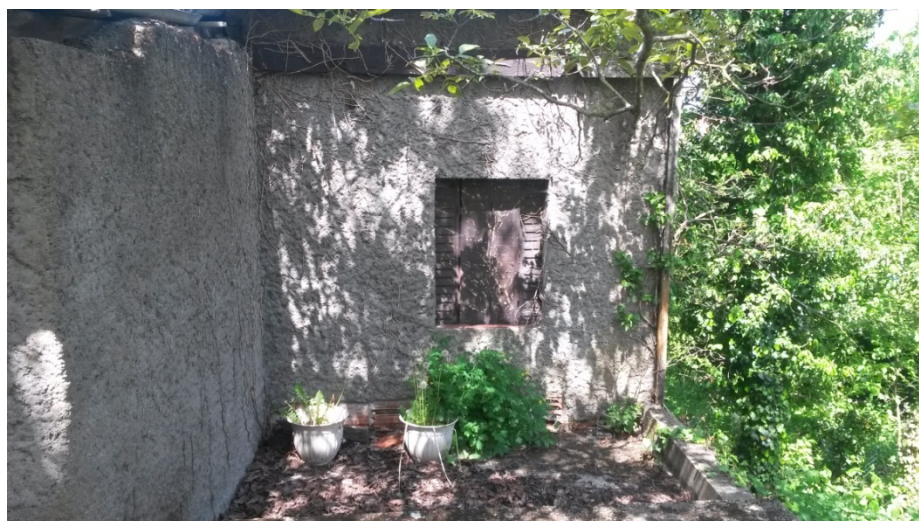
Figure 21. Espace d'accueil des ruches (renforcement à droite de la terrasse).
