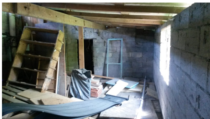
Figure 19. Premier étage du bâtiment (plancher constitué de planches et de taule).
