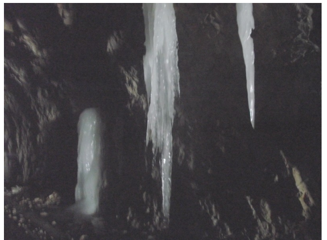
Illustration 59: Les infiltrations d'eau forment des stalactites en hiver. Photo Virgile Kéré, Mars 2015
