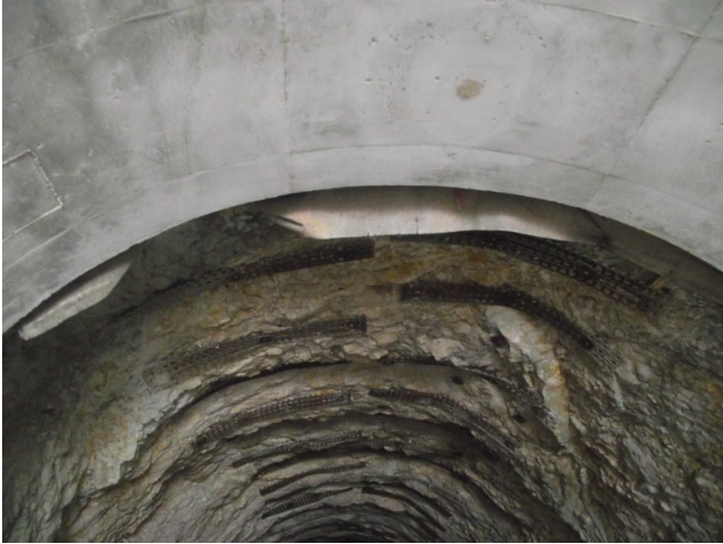
Illustration 56: Seule une partie de la voûte a été bétonnée. Photo Virgile Kéré, Mars 2015
