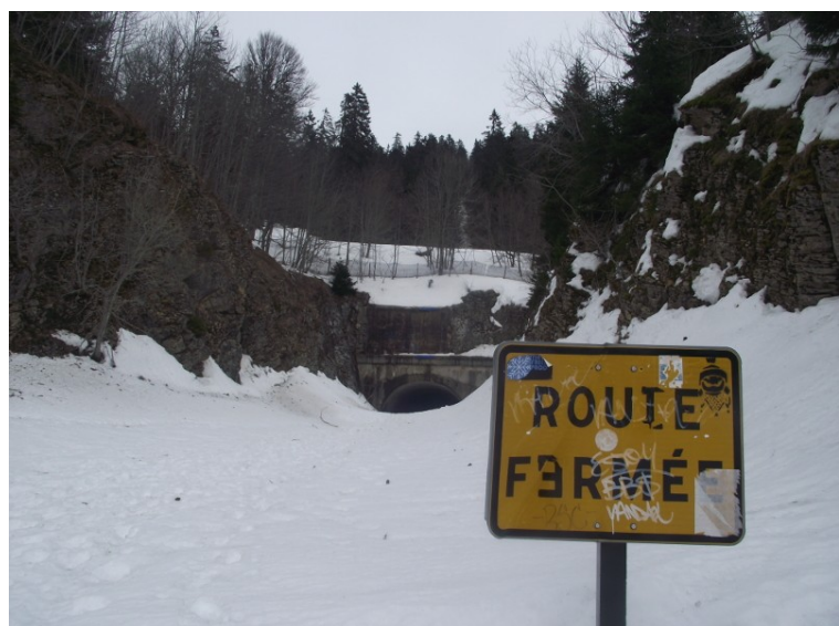
Illustration 28: Entrée sud du tunnel en hiver. Photo Virgile Kéré, Mars 2015
