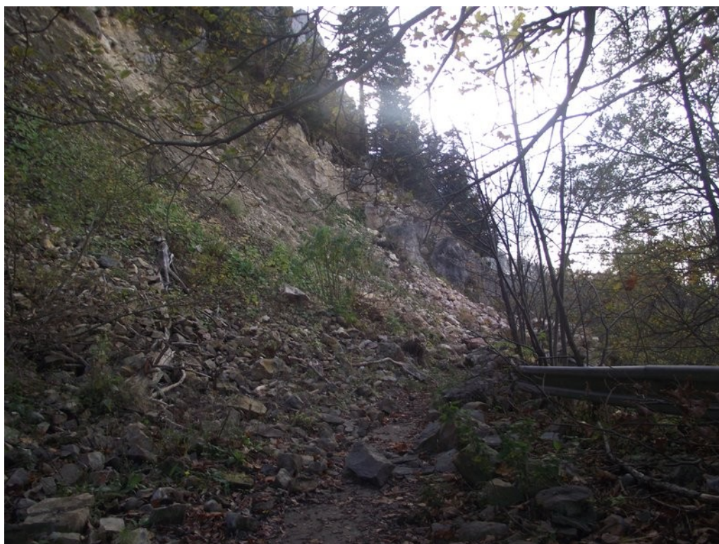
Illustration 8: L'éboulement de 1992, qui a littéralement emporté la route. Photo Virgile Kéré, Octobre 2014
