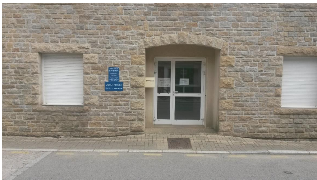
Photo 4 : Entrée immeuble cabinet médical
