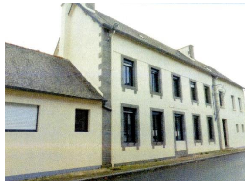
Photo 2 : Les logements sociaux vus de la rue
