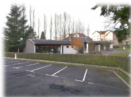
Vue depuis le parking de l'école Dora Lévi
