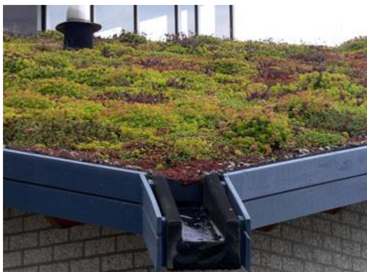
Figure 32 : Toiture végétalisée (Source : conceptpaysages.fr)
