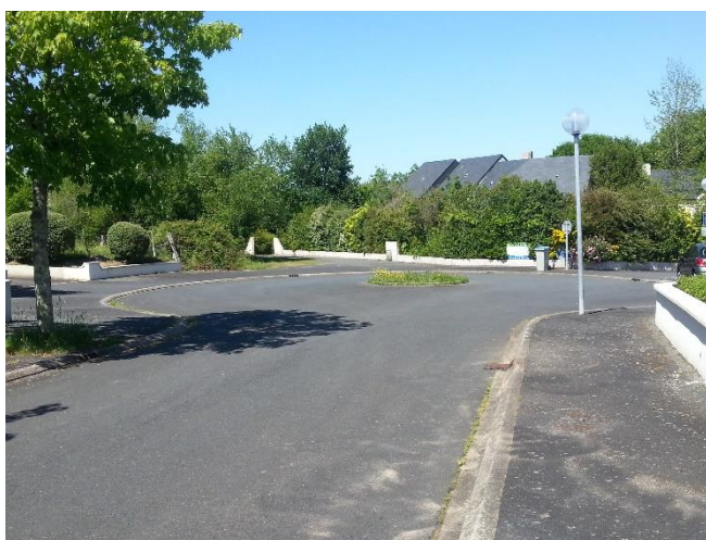
Figure 26 : Rond-point à l'extrémité de la rue des Acacias, comprenant une amorce de voirie
