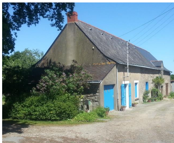
Figure 24 : Ancienne ferme, classée au patrimoine communal (Source : A. GIRET)
