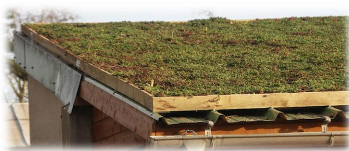
Figure 44 : Exemple d'un toit végétalisé
