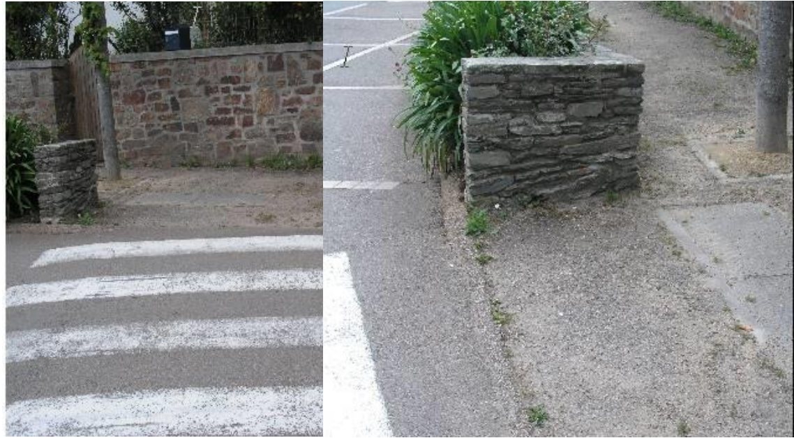
Photos 26 et 27 : abaissement de trottoir existant
