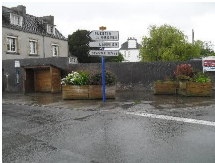
Photo 46 : ... implanté sur un trottoir large et équipé
