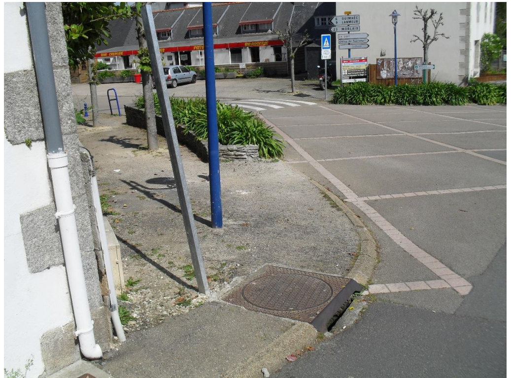
Photo 16 : Un passage piéton éloigné et mal accessible
