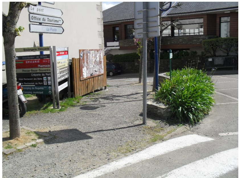
Photo 18 : mauvaise état du trottoir -1 Source : Etienne Fauveau
