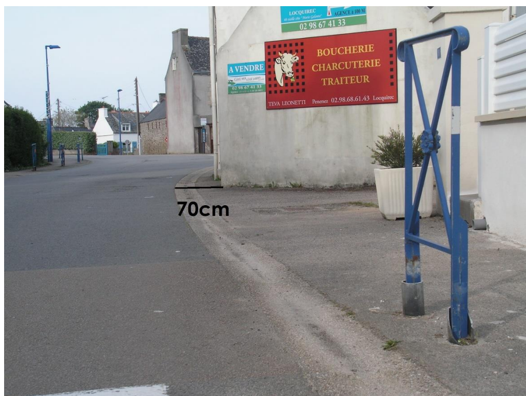
Photo 43 : largeur minimale du trottoir droite source : Etienne Fauveau
