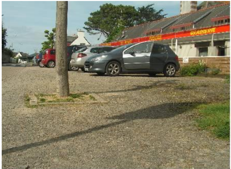
Photo 33 : Un trottoir dégradé source : Etienne Fauveau
