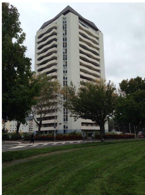
photo 15 : tour 18 étages partie nord - réalisation Crosnier.Maxime
