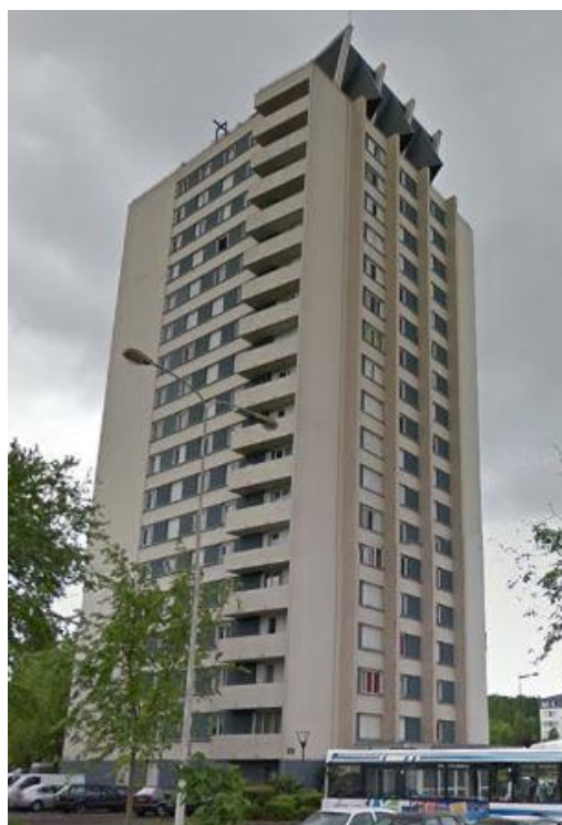
photo 6 : Tour de 18 étages partie sud du quartier - réalisation Crosnier.Maxime
