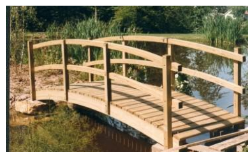
Figure 51 : Exemple de pont. Source : sciebois.fr
