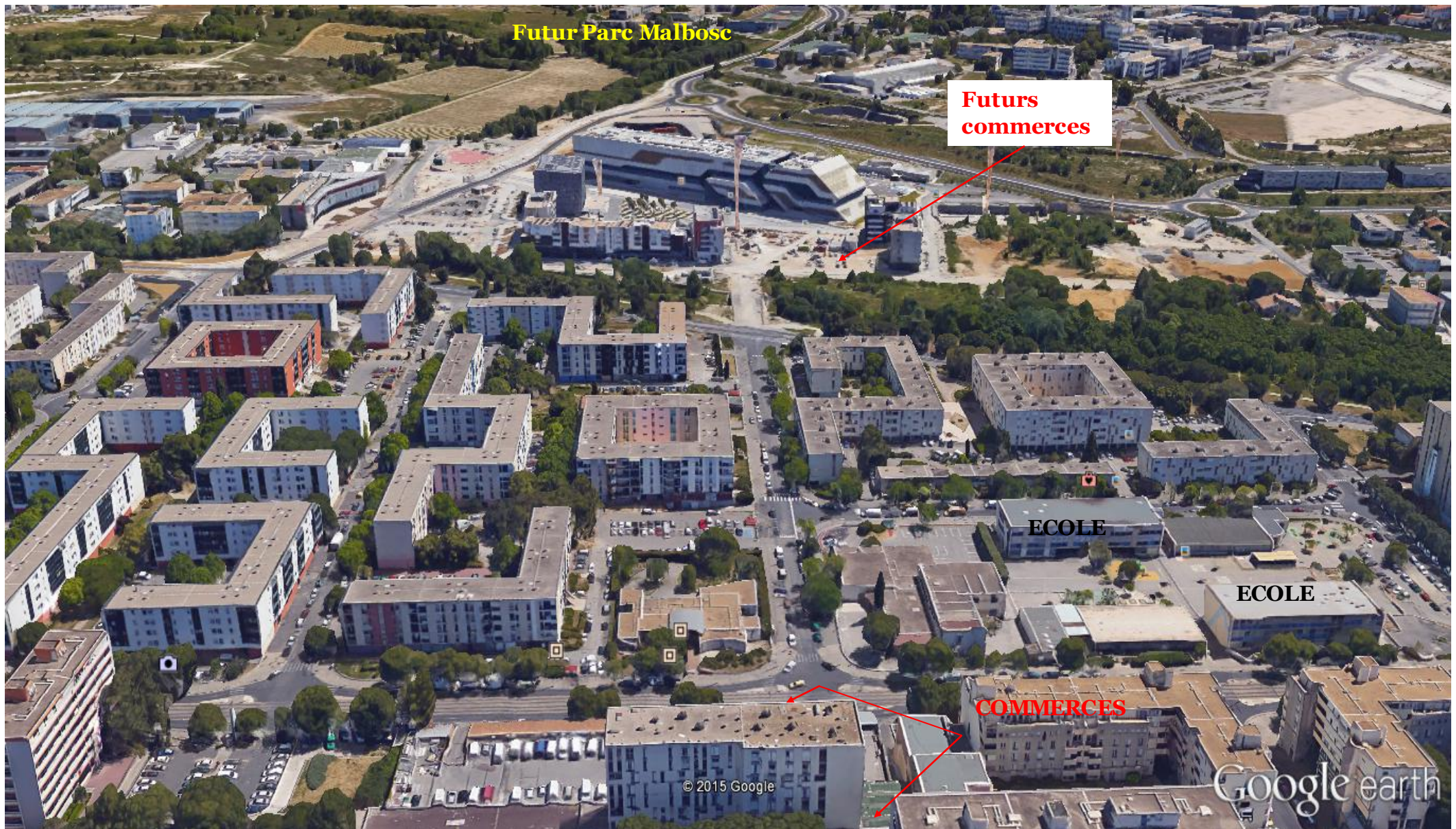
Figure 22 : Voitures et espaces verts présents dans le quartier (de la ligne de tram à l'avenue de l'Europe), Google Earth De gauche à droite : les rues Oxford, Cambridge, Saragosse, Salerne et Salamanque rejoignant ces deux dernières.
