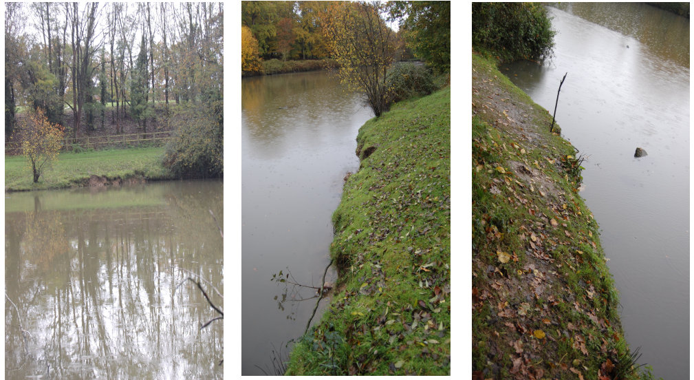
Source : Photos prises par Corentin Beldent
