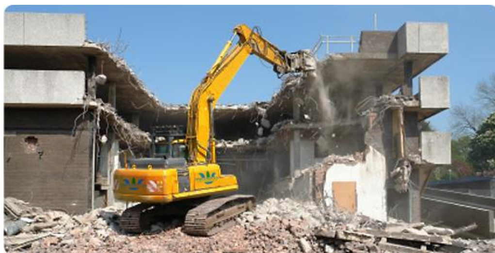
Figure 18 : Démolition d'un bâtiment (source : Google image)
