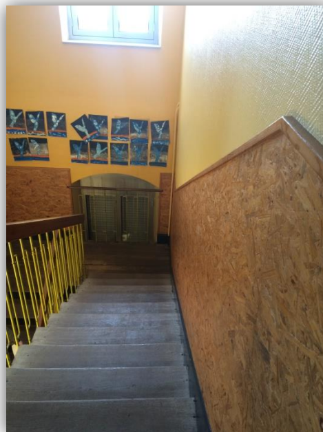
Figure 21 : Escalier menant au 1 er étage de l'école primaire de Laquenexy
