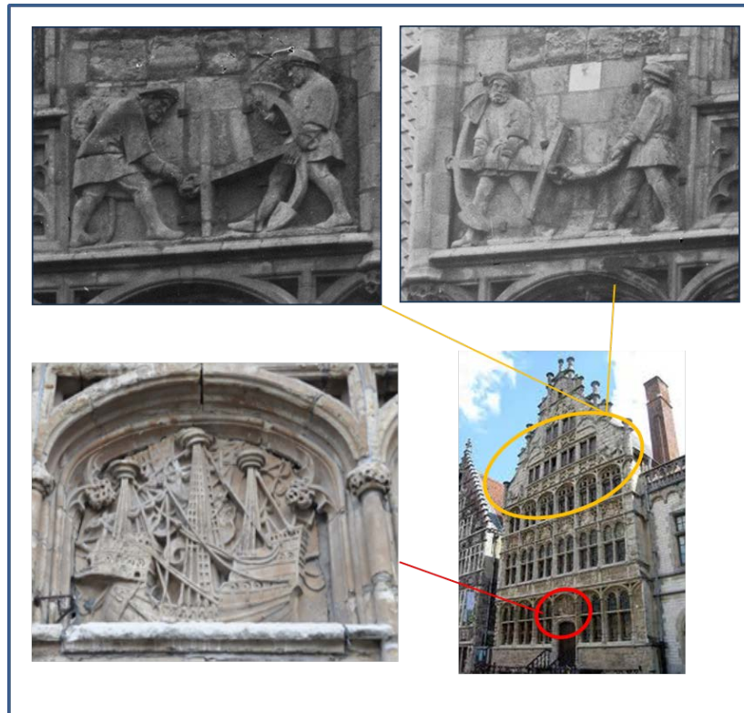
Figure 14: La façade de l'ancienne Maison des Capitaines Libres
