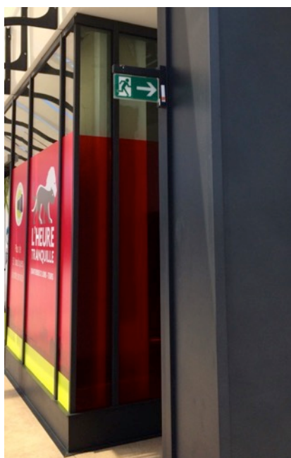
Photo 40 : Issu de secours
