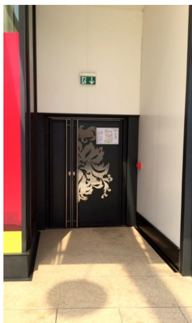
Photo 41 : Sortie de secours
