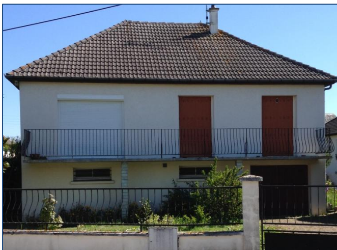
Photographie 8 : Pavillon avec garage dans le quartier Clos Furet Source : DELONIN Florian
