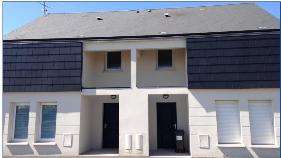
Photographie 13 : Logements sociaux sous forme de maisons mitoyennes, rue de Villerbon Source : DELONIN Florian
