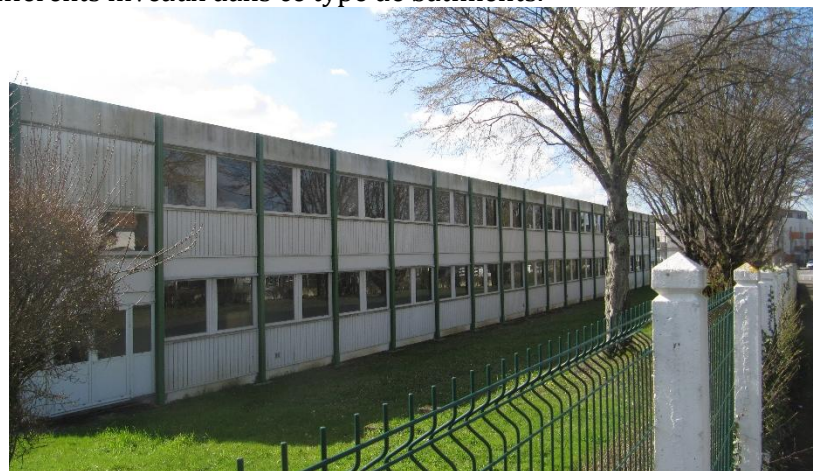
Bâtiment à structure métallique du collège
