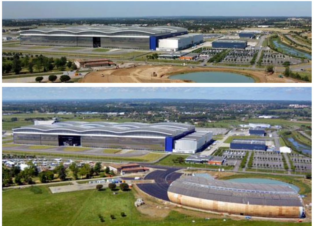
Figure 12 : Le site de Pinot avant les travaux du musée Aeroscopia comparé avec l'avancement des travaux aujourd'hui Sources : aeroscopia-blagnac.fr et airimage.fr
