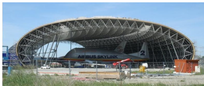
Figure 9 : Avancement des Travaux du musée au 5 mai 2014
