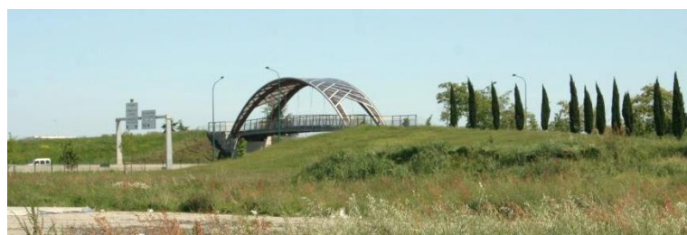
Figure 4 : Passerelle cyclable permettant de rejoindre Pinot Source : Torrent Romane
