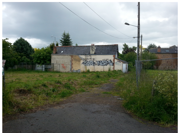
Photographie 6: Maison dégradée rue Plaisance (Claire Thuret Benoist)
