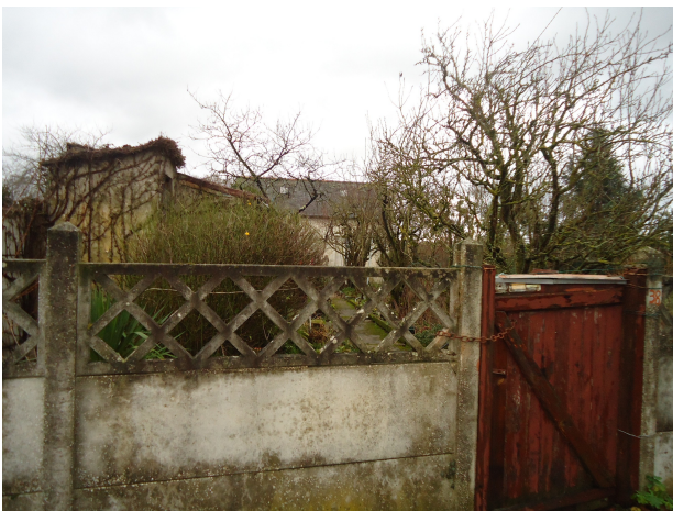
Photographie 5: Habitations dégradées rue Plaisance (Claire Thuret Benoist)
