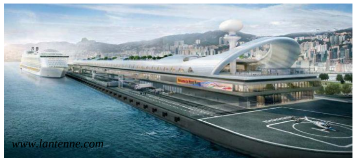
Figure 9 Terminal croisière de Hong Kong
