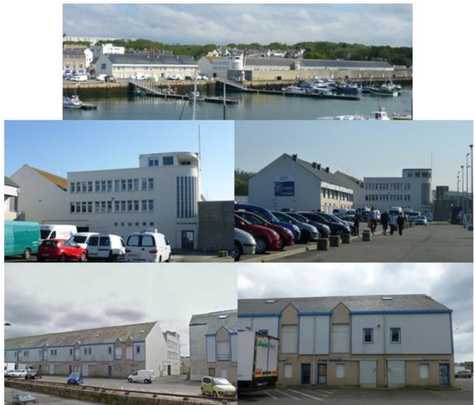
Photo 10 Différentes vues des bâtiments pouvant accueillir le centre culturel
