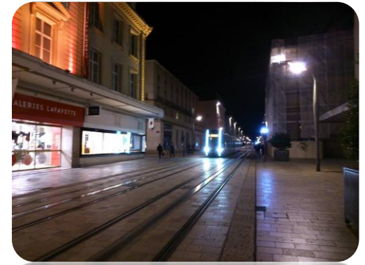
Figure 33 : Ligne de Tramway rue nationale (Crédit photo : Jordan POIMUL)
