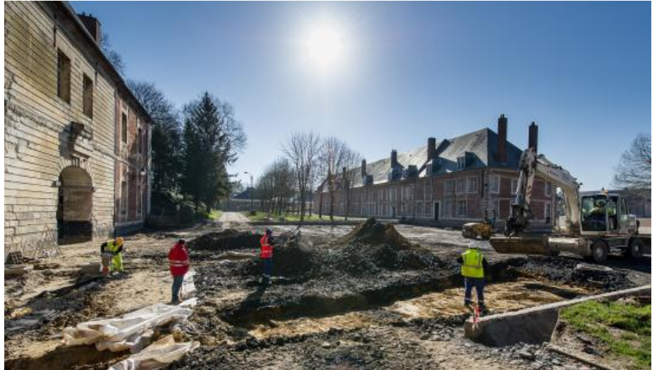
Document n°20 : Repavement et création d'une avant place (Source : voixdunord.fr )
