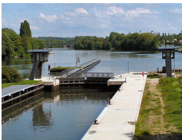
Double écluse d'Evry
