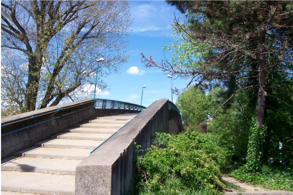
Le pont piéton reliant l'île à la zone d'activité (3)
