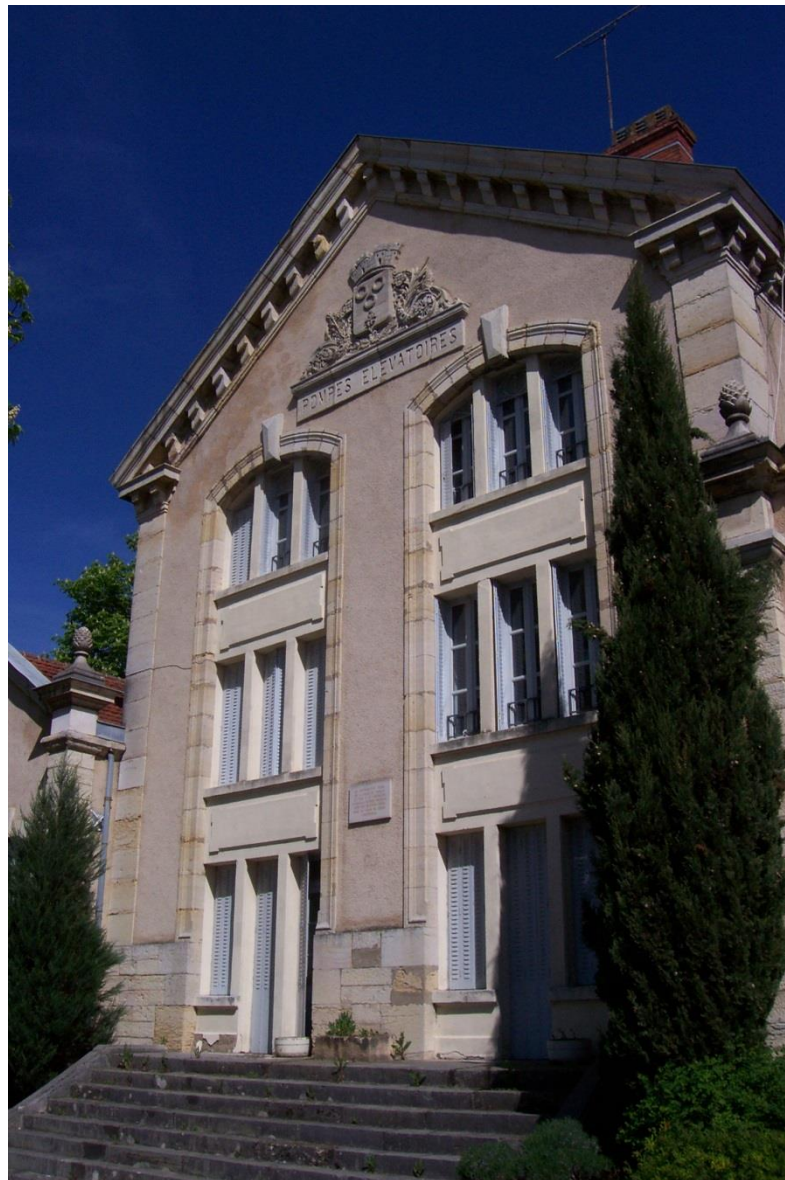
Maison des pompes éleveatoires
