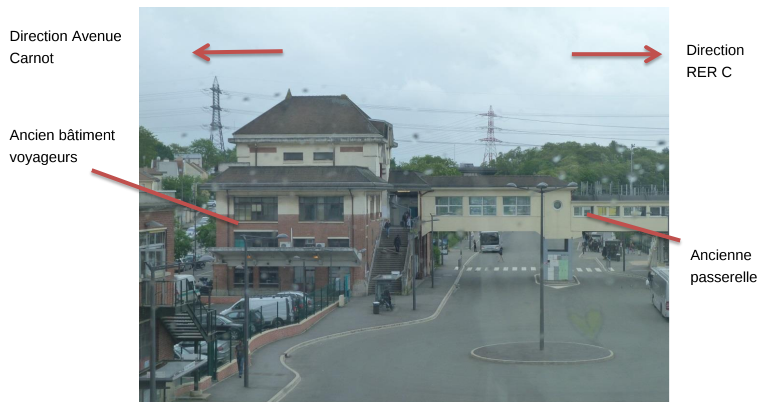
Figure 6 - Photo prise de la nouvelle passerelle, vue sur l'ancien bâtiment et l'ancienne passerelle - Source : Jade DOUGERE
