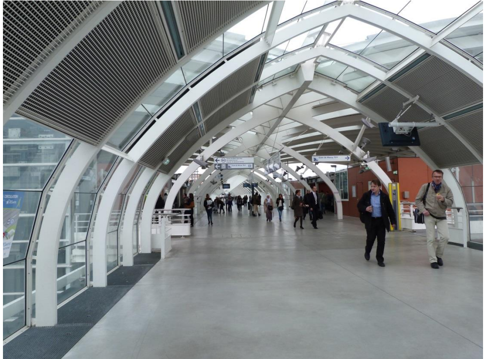
Figure 11 - Nouvelle passerelle qui relie les deux lignes de RER - Source : Jade DOUGERE
