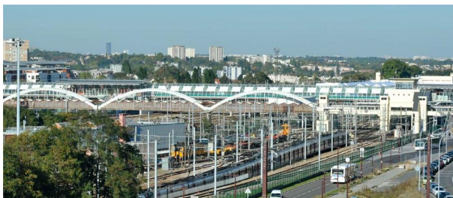
Figure 8 - Vue de l'ensemble des rails et de la passerelle - Sources : Cahiers d'acteurs
