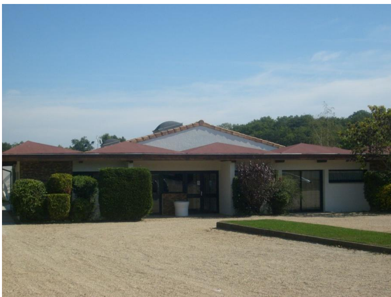
Photographie 10 – La Maison des Associations – Source Mairie de Beychac et Cailleau
