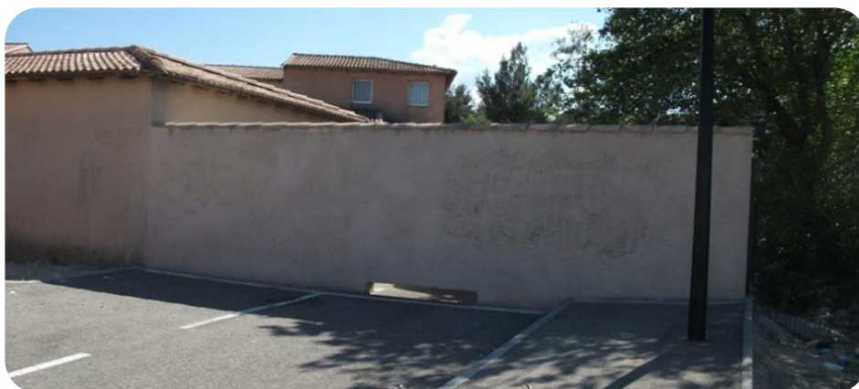
Photographie 2 : Mur construit au Sud du lycée Jean Vilar
