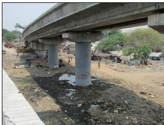
Photo 3: Pont construit pour le passage du métro
