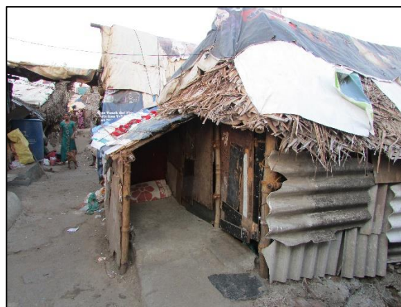
Photo 7 : Habitation de type Kutcha construite avec utilisation de matériaux de récupération, Attur Nagar
