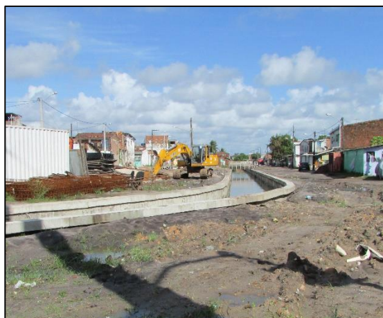
Photo 16 : Travaux de réhabilitation du canal Ibuporã Source : Hochart, 2014
