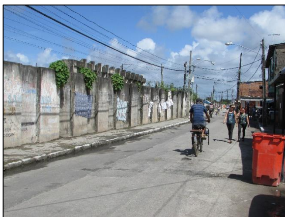
Photo 4 : Mur le long de la voie de métro, Coque
