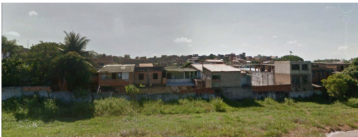
Figure 43 : Mur de séparation entre les favelas et l'avenida Luís Viana Filho ; source : Google Streetview
