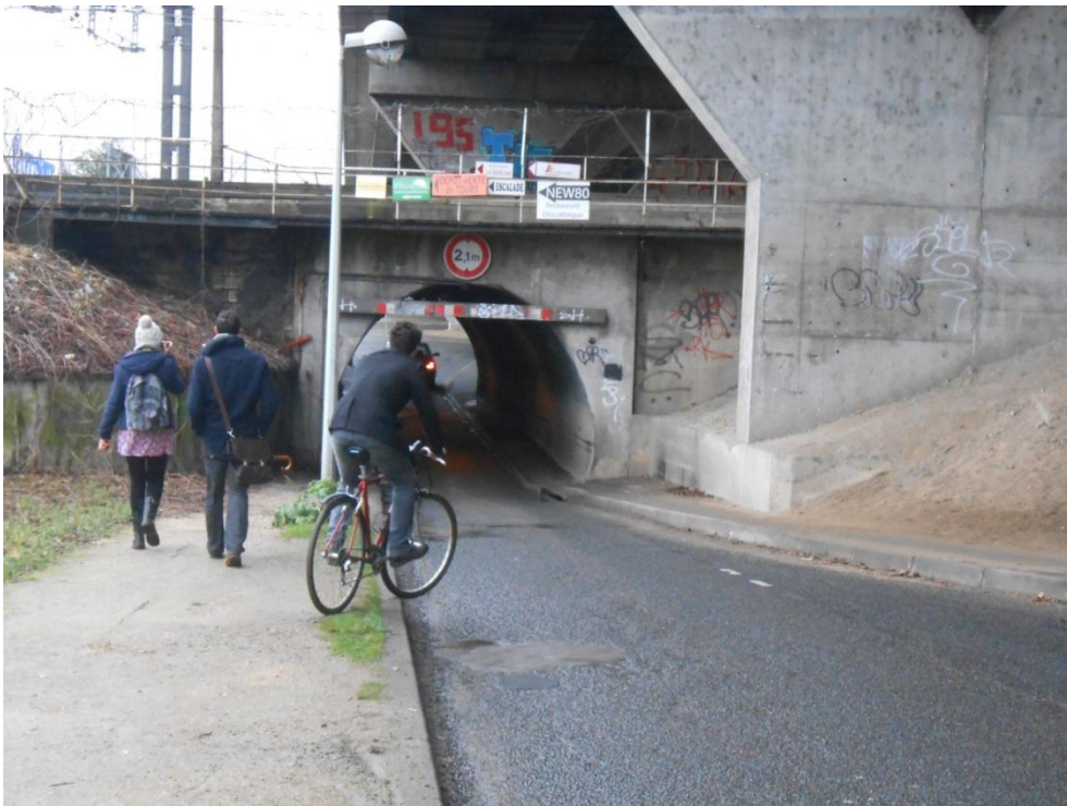
Photographie 10 : Le tunnel destiné aux voitures et aux piétons
