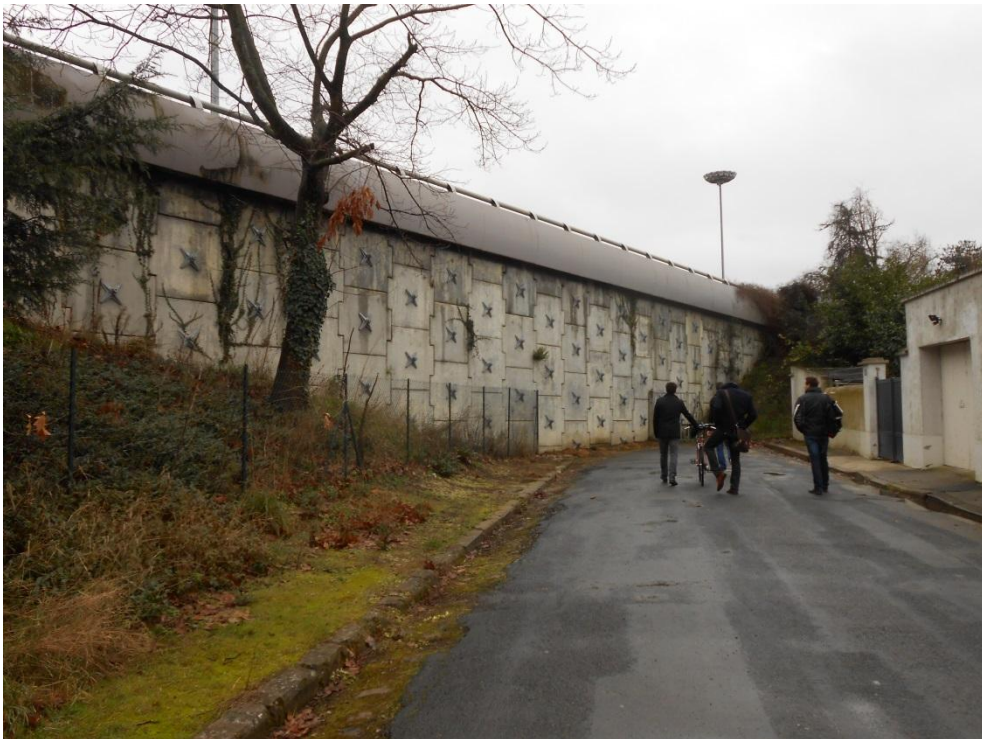
Photographie 24 : Un "mur" constitué par l'autoroute, côté Tours
