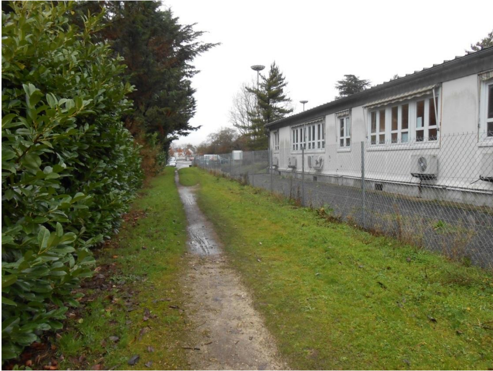
Photographie 14 : La digue, composée d'herbes et d'arbres qui protègent les habitations
