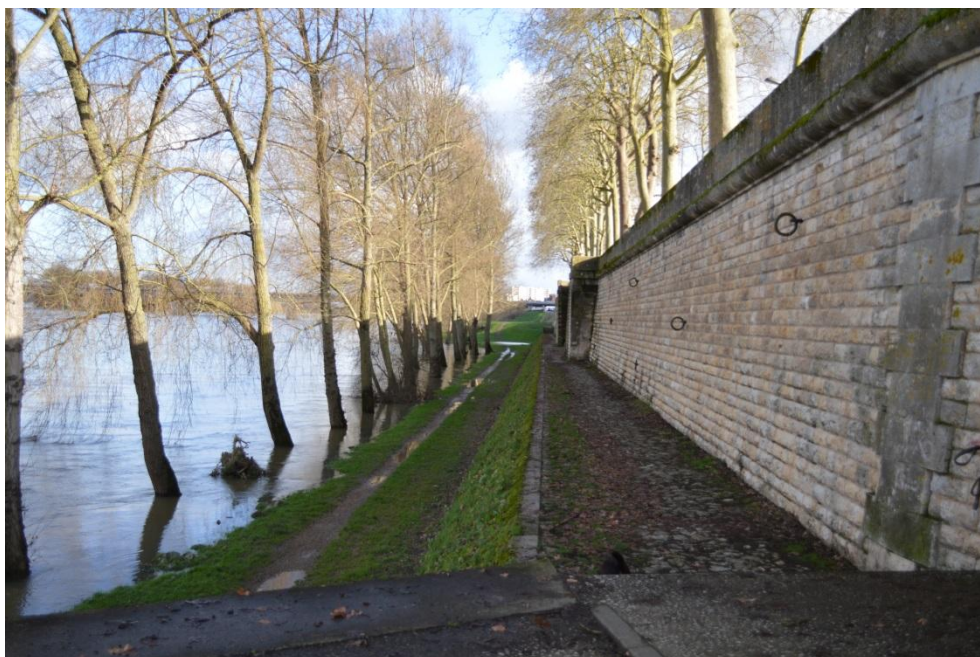
Photographie 17 : Accessibilité difficile au niveau des bords de Loire, côté Tours
