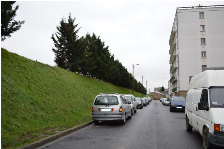
Photographie 2 : La digue, avec l'autoroute située derrière
