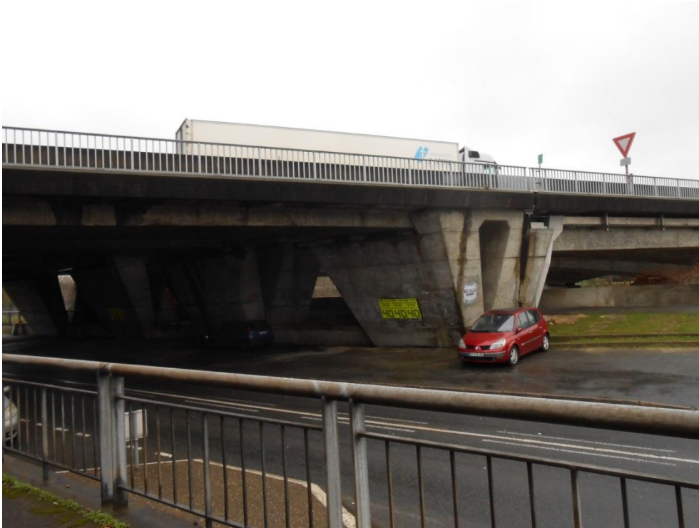
Photographie 7 : Le pont de l'autoroute aux Bords de la Loire
