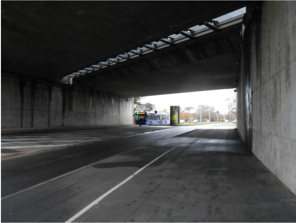
Photographie 8 : Le pont de l'autoroute, Rue Jean Bonnin
