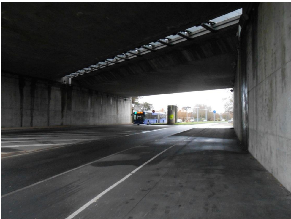
Photographie 4 : Avenue Jean Bonnin, emplacement très bruyant
