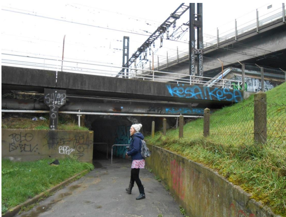
Photographie 11 : Le passage piéton sous la voie de chemin de fer
