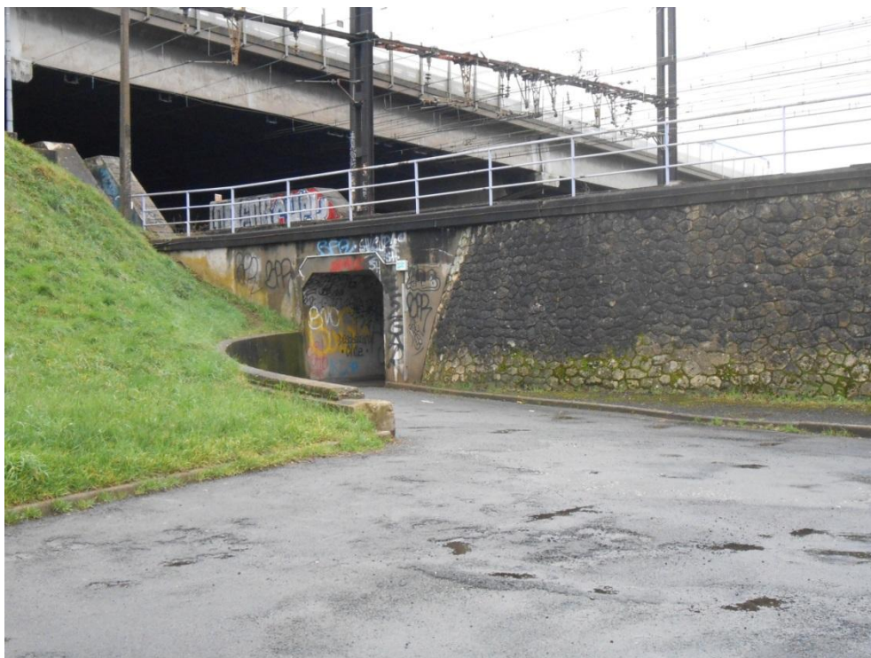
Photographie 6 : Le tunnel pour piétons, sous les voies de chemins de fer
