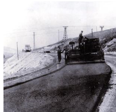
Figure 7: Pose du revêtement de la route en 1962
